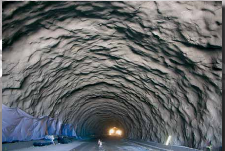
Vista de túnel excavado
